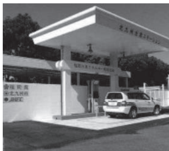
▲水素ステーション
