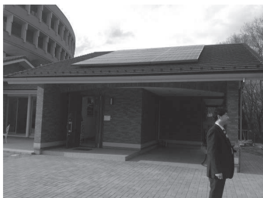
▲スマートハウス実習棟の外観
