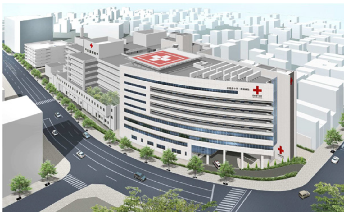
図4-2 新棟建設（2017年2月末グランドオープン）
